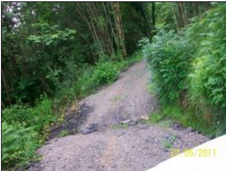
Pista en zona de vaguadas que vierten hacia arroyo Errekaetxe (Amunategui)
